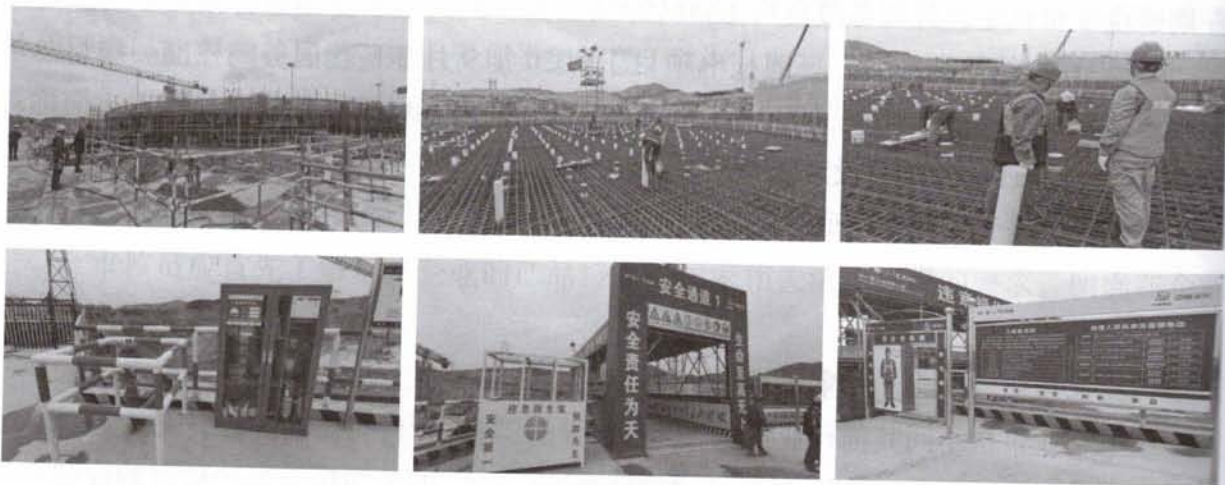
图1 三澳核电项目核岛主体施工现场
